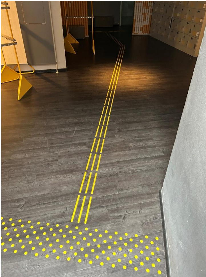
Leitsystem im Untergeschoss
